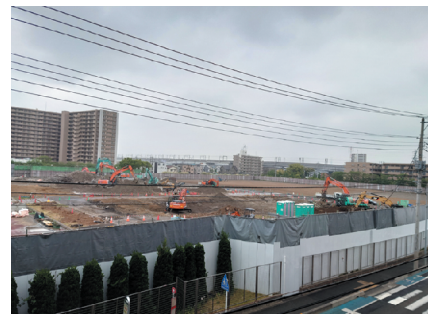
大型物流施設の建設予定地(5月15日撮影)
